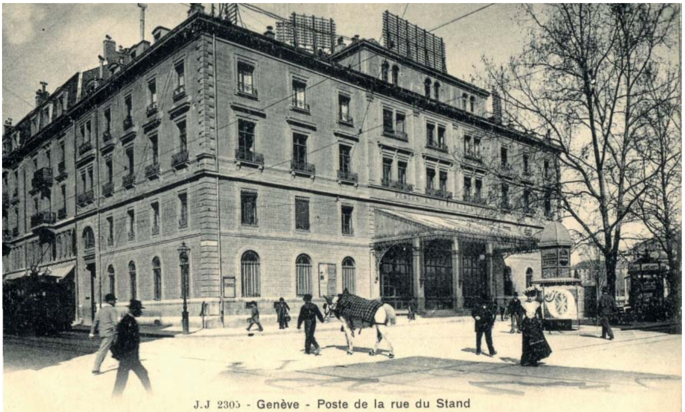
Fig. 47 ■ Poste de la rue du Stand - 1204 Genève - cité
