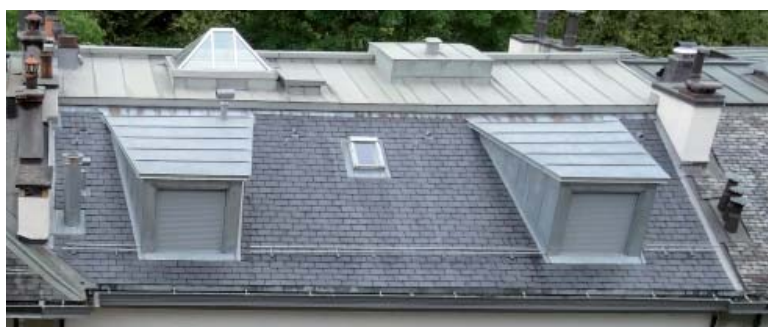
Fig. 9 - Lucarnes jacobines à pignons en molasse avec double fenêtre.
