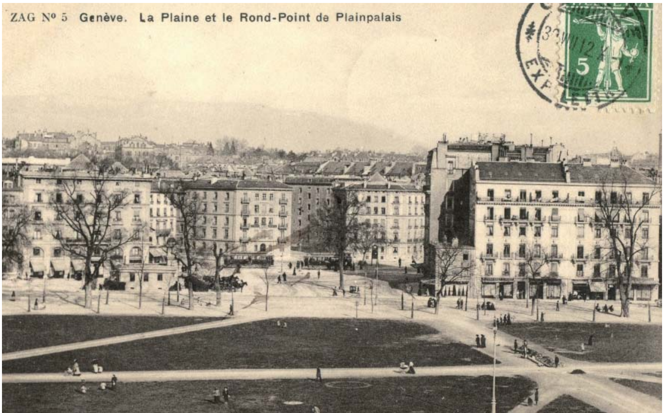
Fig. 53 ■ La Plaine et le Rond-Point de Plainpalais vers 1900 - On remarque l'absence de lucarnes.
