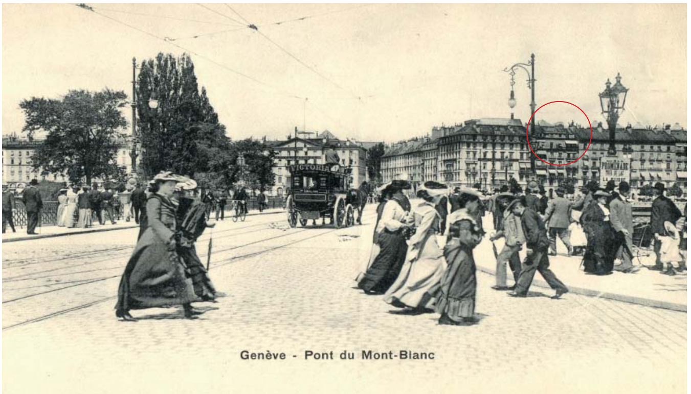
Fig. 45 ■ Pont du Mont Blanc - 1201 Genève - cité
