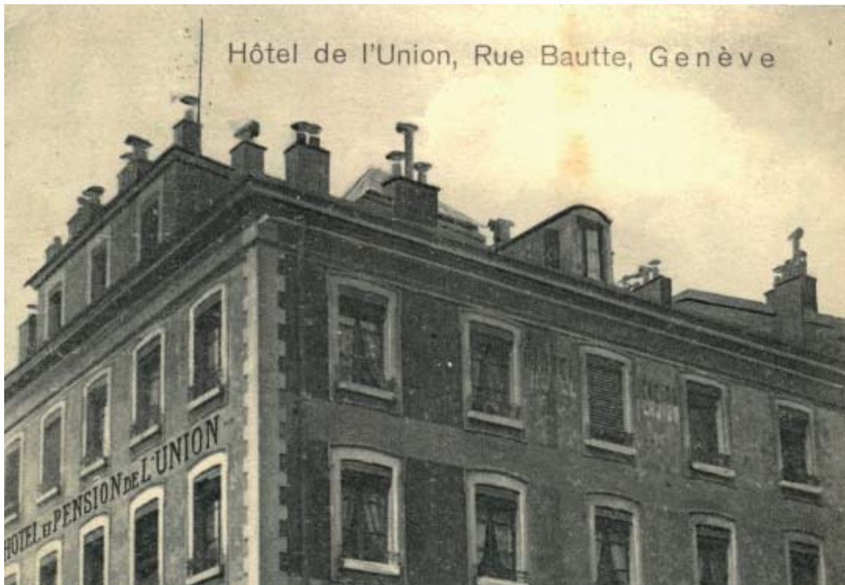
Fig. 51 ■ Hôtel de pension de l'Union, rue Bautre - 1201 Genève - cité
